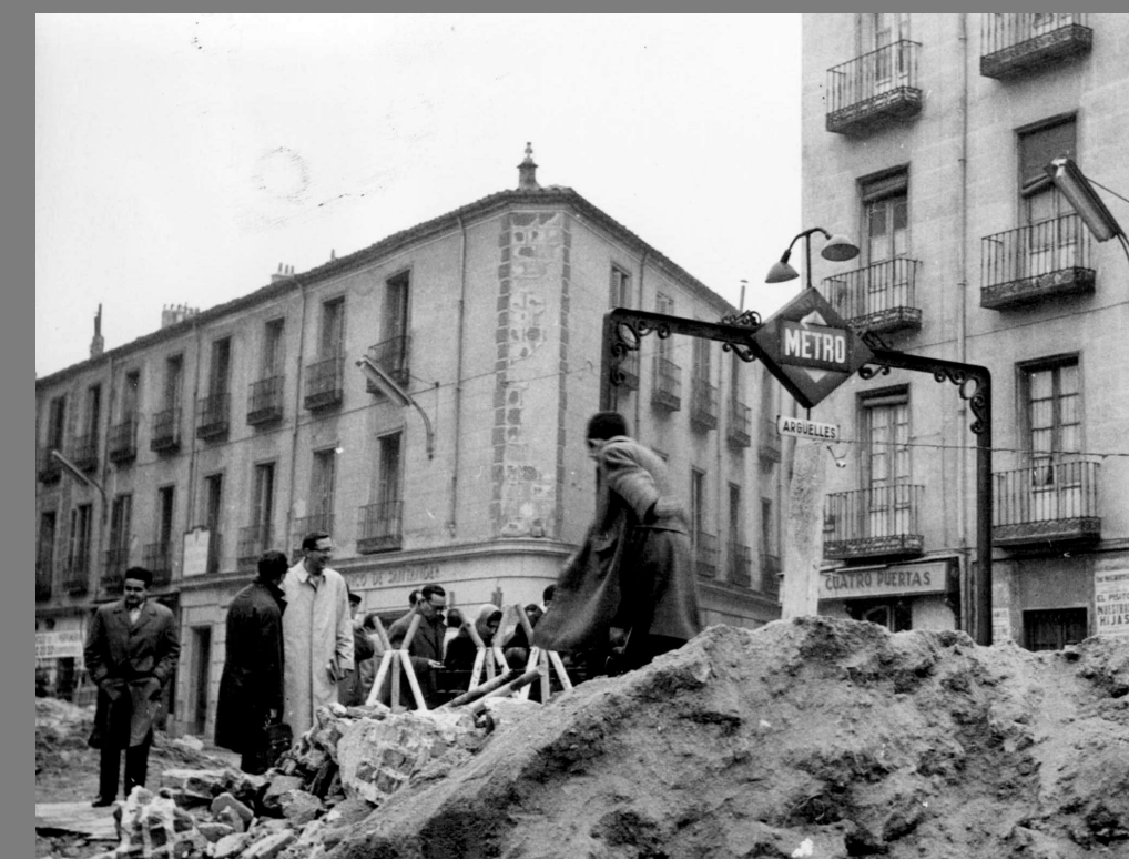
Nuevo acceso de la estación de Argüelles, 1960 [Teodoro Naranjo Domínguez, Archivo ABC]
